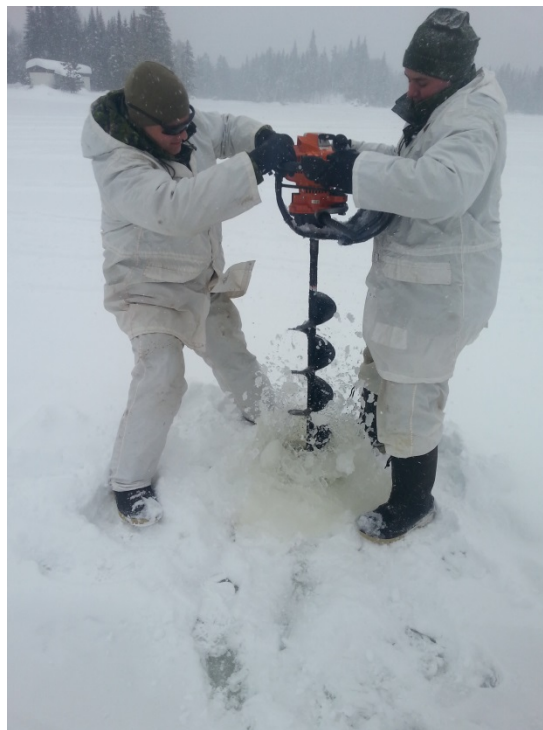
Des membres du 51e escadron de génie du 5 RGC percent un trou dans la glace recouvrant le lac Hayes pour y installer des pompes à eau.
