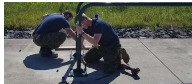
Le Cap Ovens, à droite, et l'Avr Hatch, à gauche, installent de l'équipement sur l'aire de trafic.
