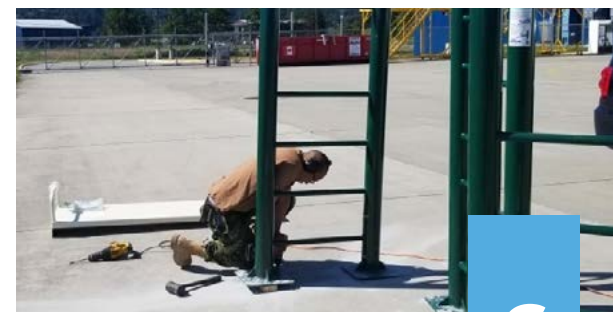
Le Cpl Kim perce des trous dans la base afin de fixer les ancrages.
