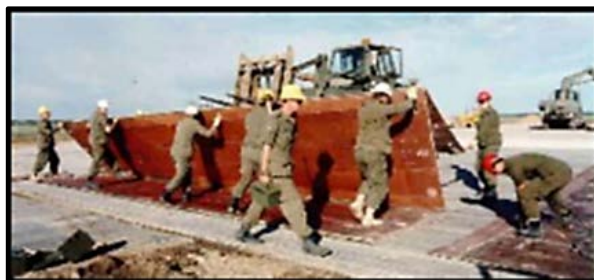
Figure 1-29 Entraînement du personnel du génie construction
