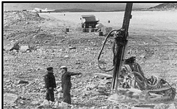
Figure 1-26 Construction d'un terrain d'aviation dans le Nord
