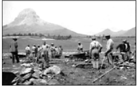
Figure 1-14 Des membres du génie supervisent des projets de construction pendant la Crise de 1929
