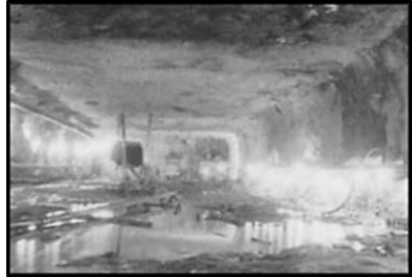
Figure 1-25 Construction du poste de commandement du NORAD à North Bay
