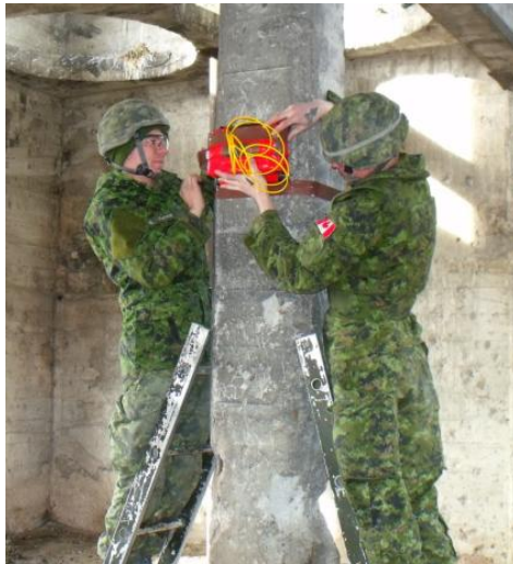
Le Sap Lelacheur et le Cplc Porter installent les charges explosives coupantes
