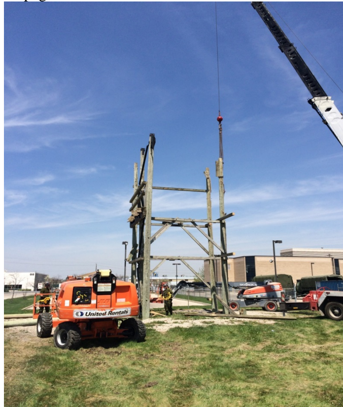
Les sapeurs du 2 e RGC retirent ce qui reste du contreventement avant de couper les poutres.
