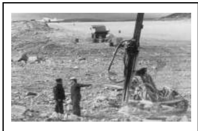
Figure 1-31 Construction d'un terrain d'aviation, Nord canadien
