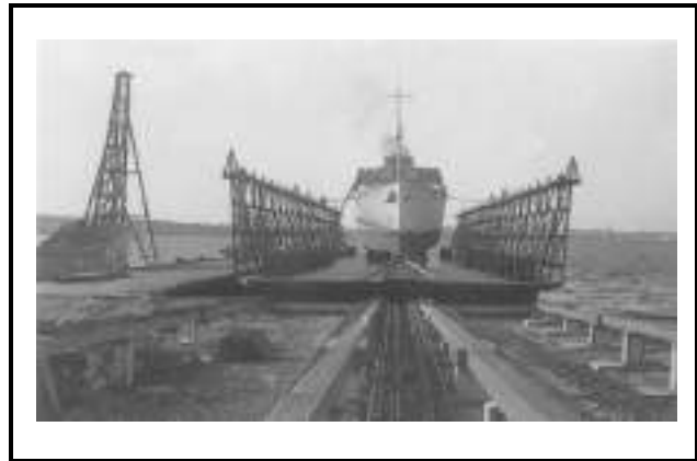
Figure 1-17 Installations de réparation de Sydney (N.-É.)
