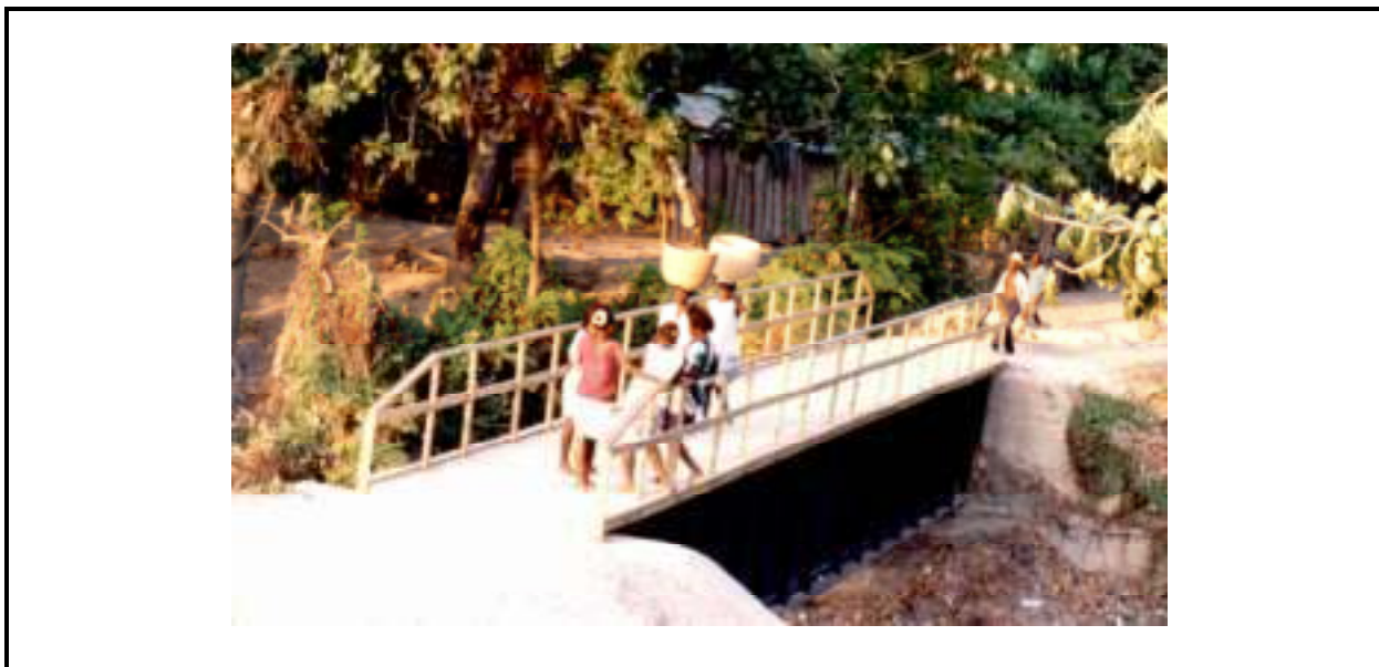
Figure 1-32 Passerelle à Haïti
