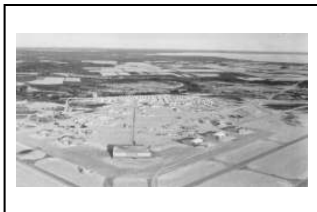
Figure 1-24 Station de l'ARC à Cold Lake
