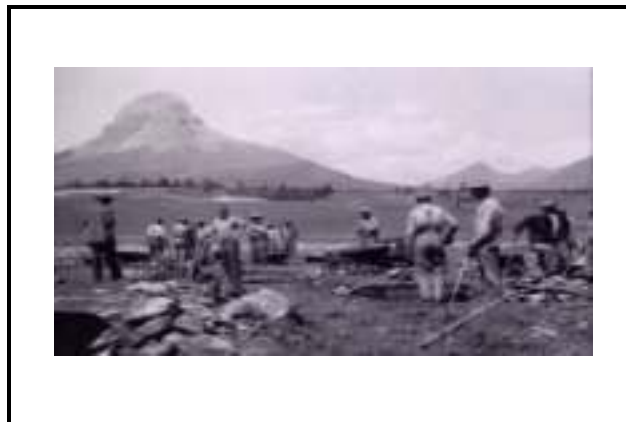
Figure 1-15 Les ingénieurs supervisent des projets de construction pendant la Grande Dépression
