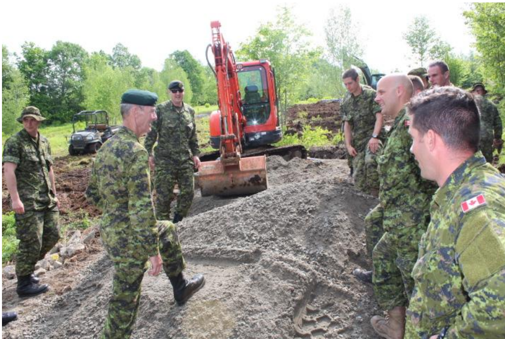
Le colonel commandant inspecte le travail d'écoulément effectué sur la piste de conditionnement physique sur le site de l'ancienne colline de ski. Le Col avait déjà travaillé sur la même colline alors qu'il était au grade de Cplc.
