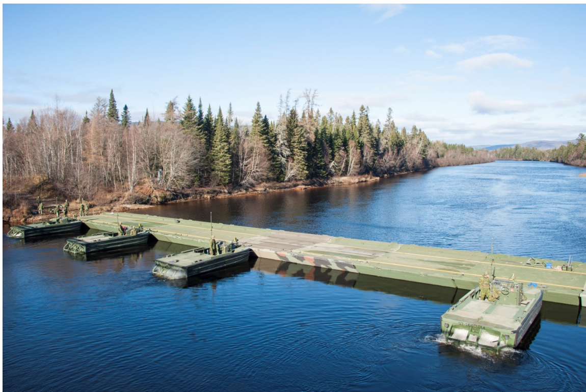
Le 53e escadron de génie du (5 RGC) a construit un pont flottant sur la rivière Jacques-Cartier.
