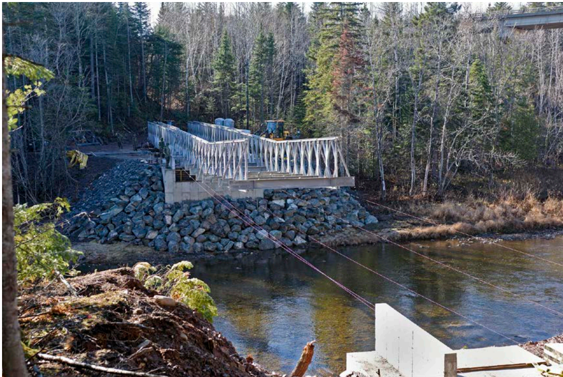
Des membres du 4 RAG, de Gagetown, poussent le pont ACROW qui enjambe la rivière Tetagouche, à l'extérieur de Bathurst, au N. B., durant l'Ex NIHILO SAPPER 16.
