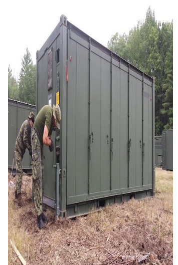
Cpl Wilson, Tech PC et Cpl Buisman, Tech DE, mettant à niveau une unité d'ablution sur terrain accidenté.
