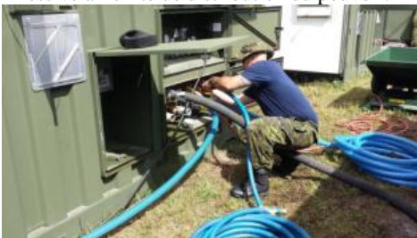
Cpl Sohn, Tech Const, connectant les boyaux à l'unité de lavage de véhicule.
