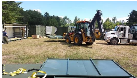
Une pépinière de la troupe d'équipement lourd est venu donner une capacité de levage. De plus, un contracteur est vidange les eaux usées.
