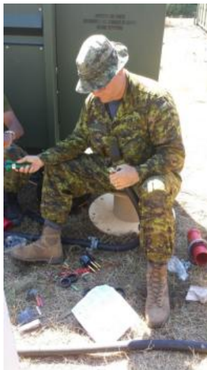
Sgt Humber, Tech ED, installe les connecteurs aux câbles électriques.
