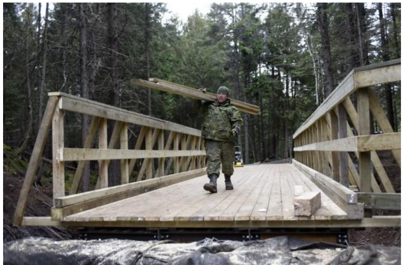
Un pont a été construit au parc Rockwood pour la communauté locale par les membres du 4 RAG dans le cadre de l'exercice Nihilo Sapper en novembre 2015. Photo par : l'Adj Jerry Kean, 5 Div CA
