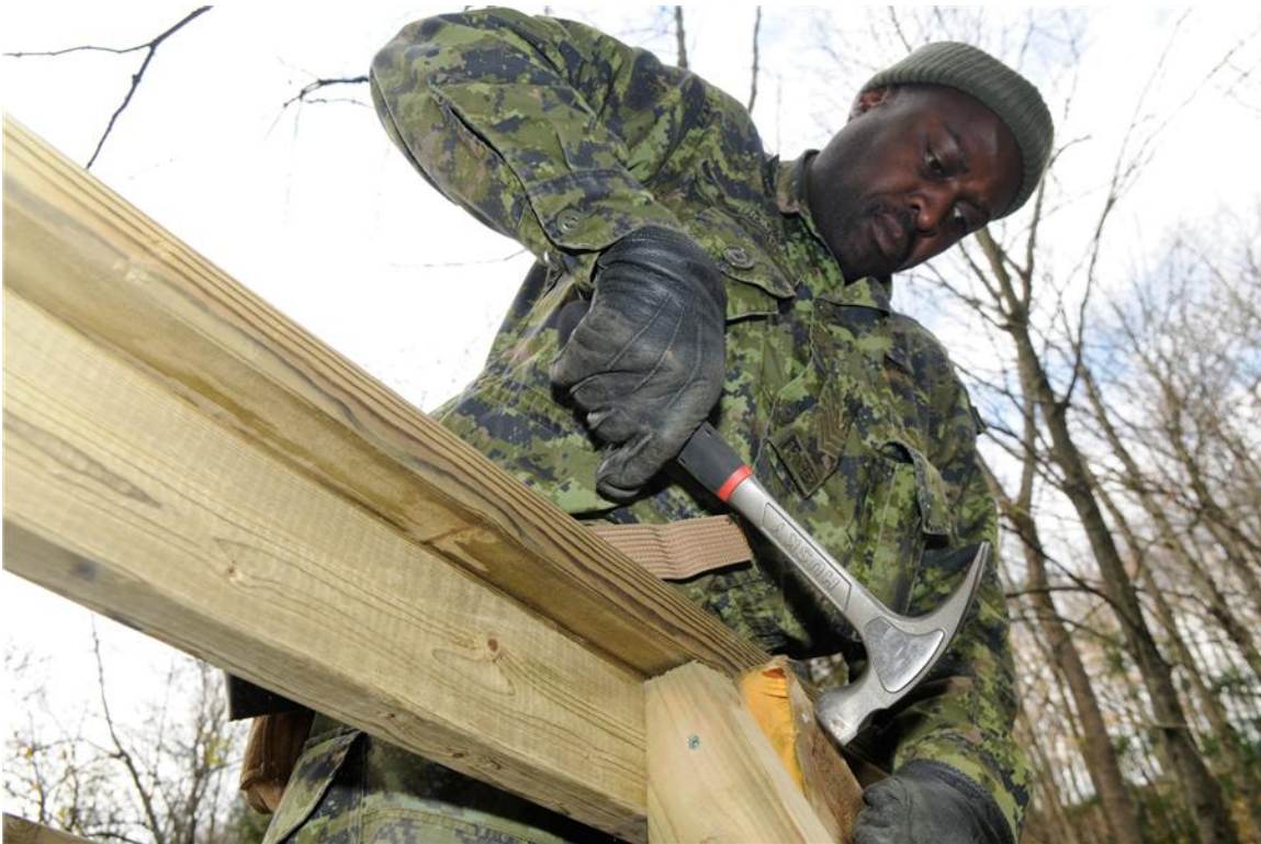
Le Cpl Hai Dai fixe le renfort inférieur pendant la reconstruction de la passerelle du ruisseau Mill, sur le Sentier transcanadien, près de Ravenna, en Ontario
